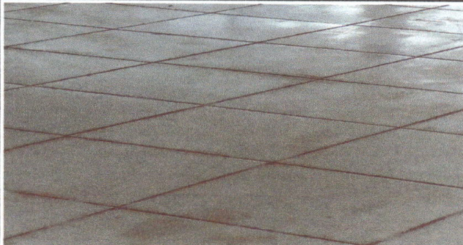
Foto 4: Se observa la instalación de piso en las aulas terminadas
