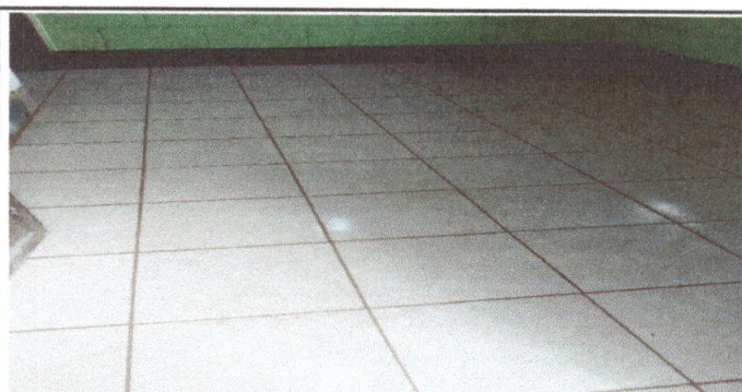
Foto 6: Se observa la instalación del piso en la bodega terminada.
