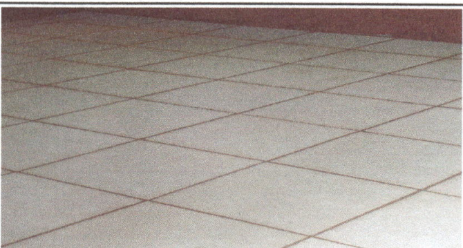
Foto 5: Se observa la instalación de piso en la dirección terminada
