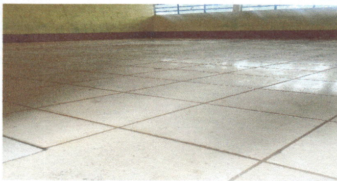
Foto 3: Se observa la instalación de piso en aula terminadas.
